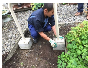
錆びて腐食した部分が剥離してきています。経年劣化の具合は目視だけでなく触って確認してみることも大切です。
