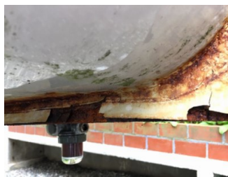
錆びて腐食した部分が剥離してきています。経年劣化の具合は目視だけでなく触って確認してみることも大切です。
