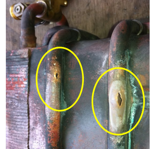
風呂釜の凍結破損個所です
