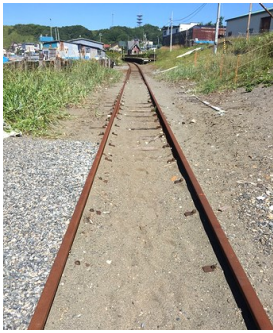
マルセイのすぐ横の線路
