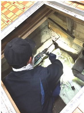
床下に潜った気田くんが車庫に通じるブロックにドリルで穴をあけて、新しい配管設置に取り組みました。どんどん仕事を覚えていく気田くんを、英司くんも社長と一緒にサポート。会社の環境整備も、若い二人が次々と取り組んでくれています。うれしいです！ ^^
