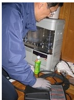
タンクからストーブまで送られる灯油配管をコンプレッサーでしているところです。いずれも、次の冬が来る前にご相談下さい。
