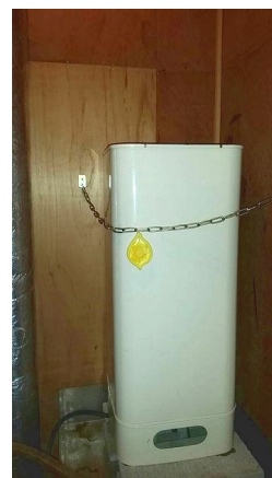
屋内設置に多く利用されている90リットルタンク
