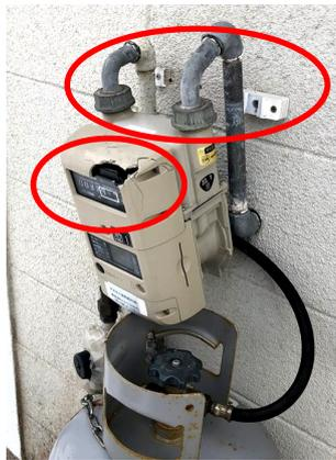
右の写真をご覧ください。屋根から落ちた雪は、雪というよりも大きな氷の塊ですね。雪の重みは想像以上ですが、これがマイコンメーターを直撃。メーターの一部が砕け、ガス管にも亀裂が入るほどの損傷を受けました。
