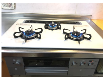
ビルトインガスコンロの設置工事をしている恭平くん。設置後は、きれいな青い炎を確認して工事終了となります。
