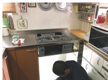
ビルトインガスコンロの設置工事をしている恭平くん。設置後は、きれいな青い炎を確認して工事終了となります。
