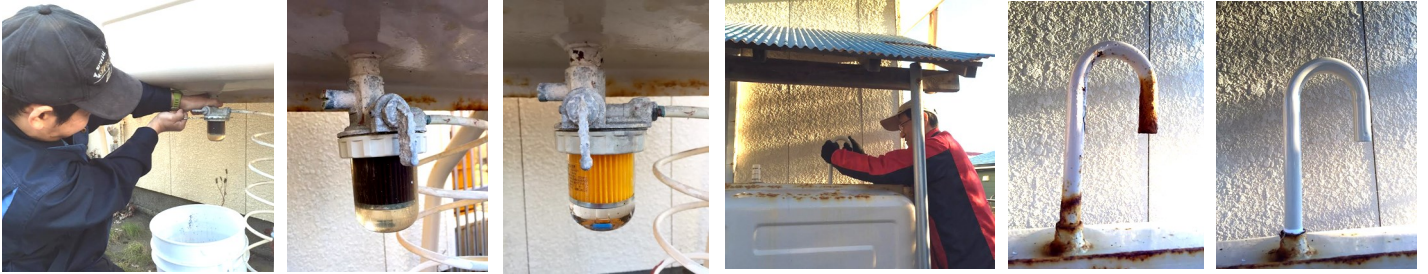
腐食が進んでしまった「空気抜き管」を交換している社長
